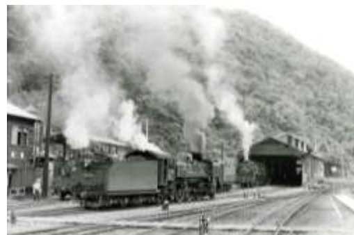
備後落合駅にあった蒸気機関車の機関区 昭和42.8.12 (200407-5550) 奥が機関庫、左側に石炭の給炭台の屋根が見える。昭和40年代前半まで、ひなびた山間の狭い敷地内に、常に複数の蒸気機関車が待機していた。
