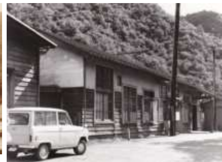
備後落合駅 昭和46.8.15 (200407-5550) 駅舎の建物は、窓がサッシになった以外はほぼそのままの形で現存する。
